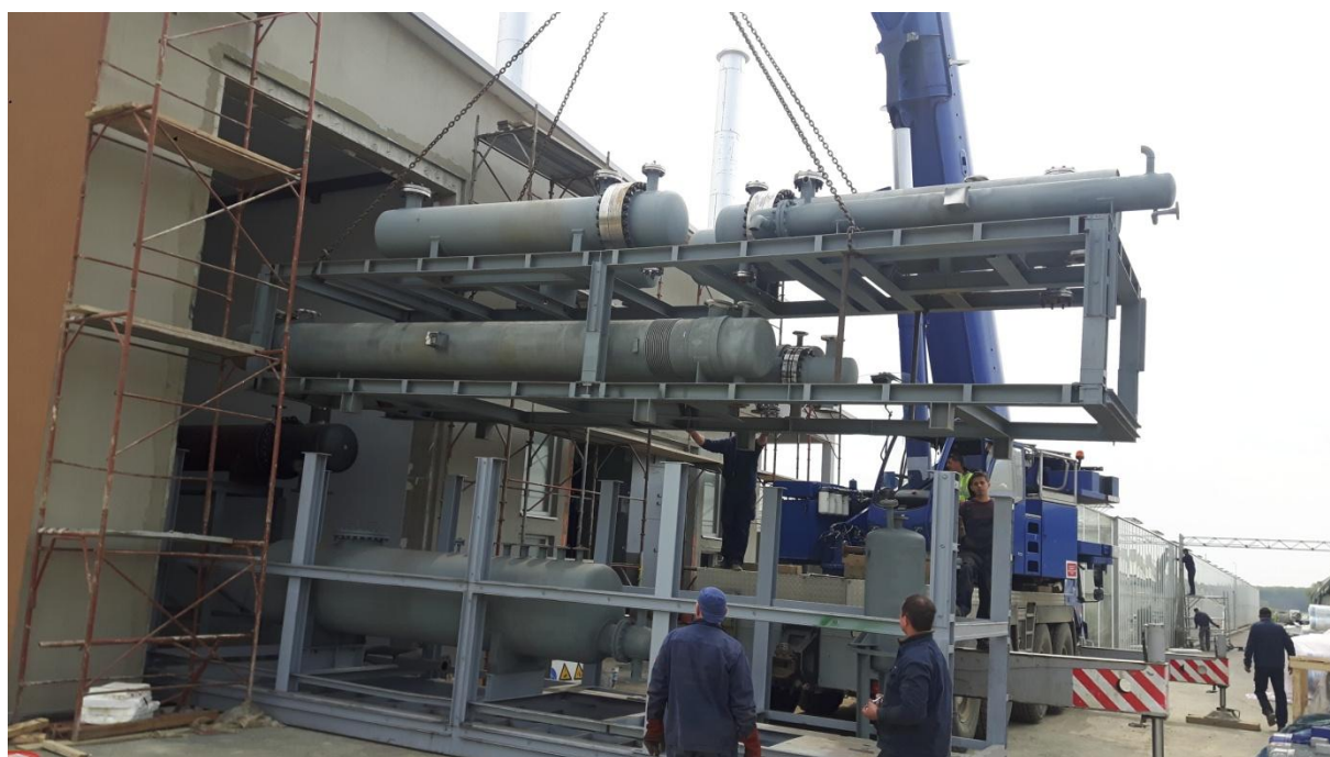
Slika 3: ORC modul kogeneracijskog postrojenja
