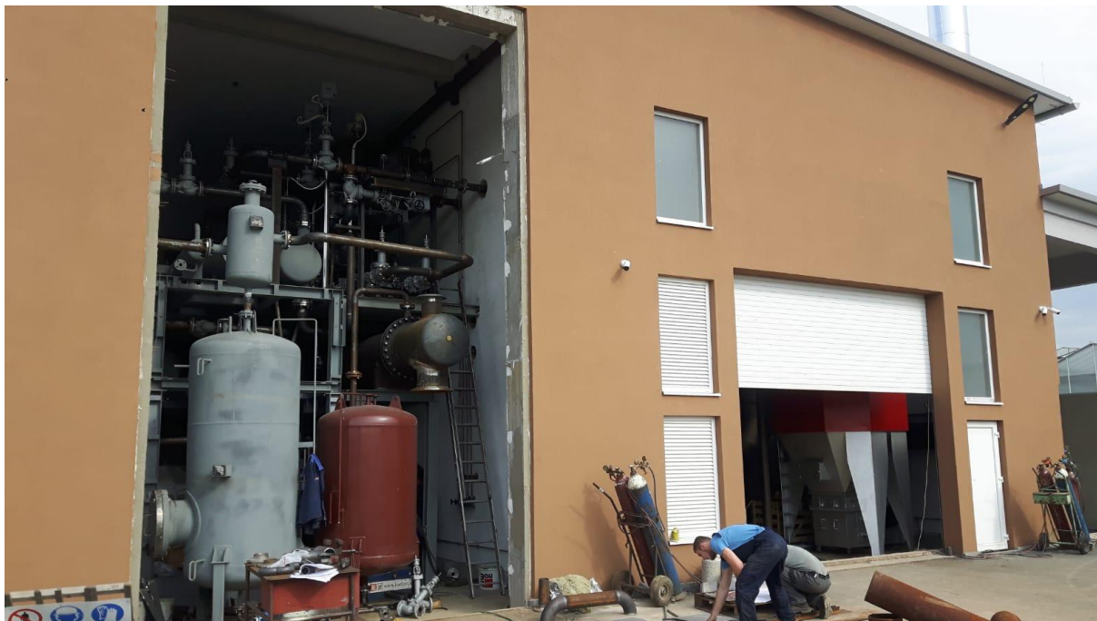
Slika 5: ORC modul i kotlovski dio kogeneracijskog postrojenja
